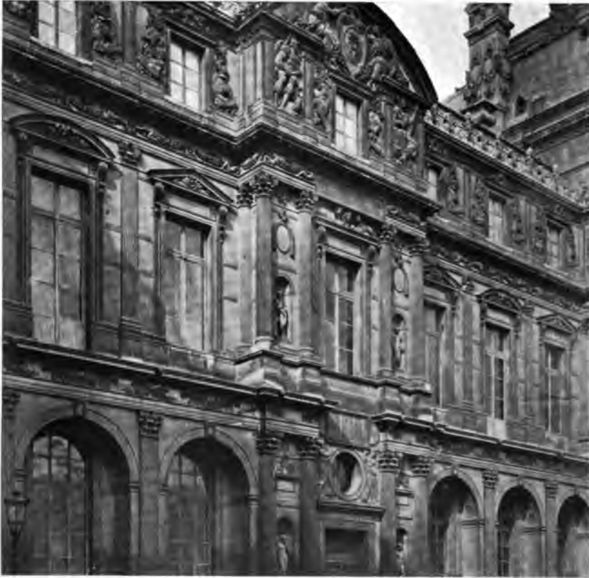
Fig. 92. — Fenêtres dans l'aile du Louvre de Pierre Lescot. Frontons sur consoles abritant les fenêtres.
